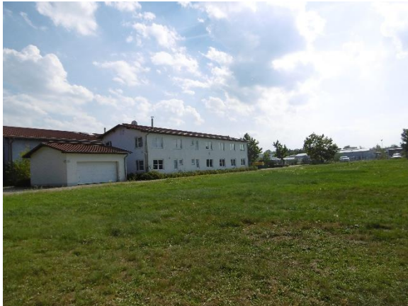
Abb. 5 Bestandsgebäude. Das neue Gebäude soll links entstehen. Blick nach Süden. LaN, 22.08.2023
