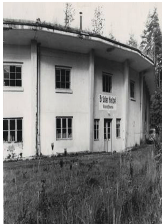
Gebäude Nr.222: „Bananenbau“. Neuanfang nach 1945 Glasraffinerie Fa. Helzel, ehemals Nordböhmen
